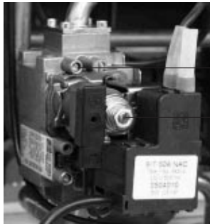
B Meßnippel D Einstellschraube
