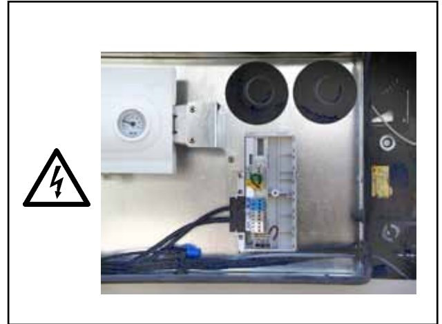
Bild: Anschlusskasten MGK-170/210/250/300 Gefahr durch elektrische Spannung
